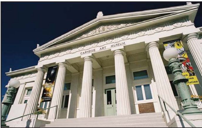
Arquitectura Neoclásica Biblioteca Carnegie en Oxnard, CA
